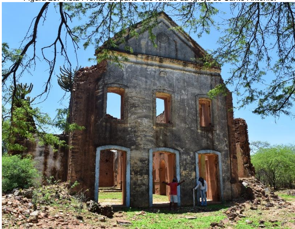
Figura 20: Vista Frontal de parte das ruínas da Igreja de Santo Antônio.
