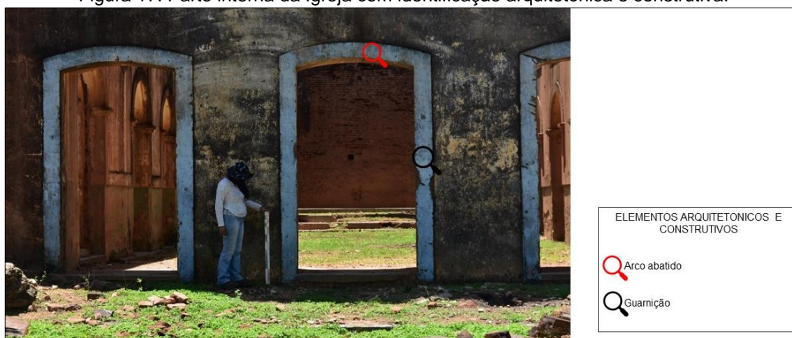
Figura 17: Parte interna da Igreja com identificação arquitetônica e construtiva.
