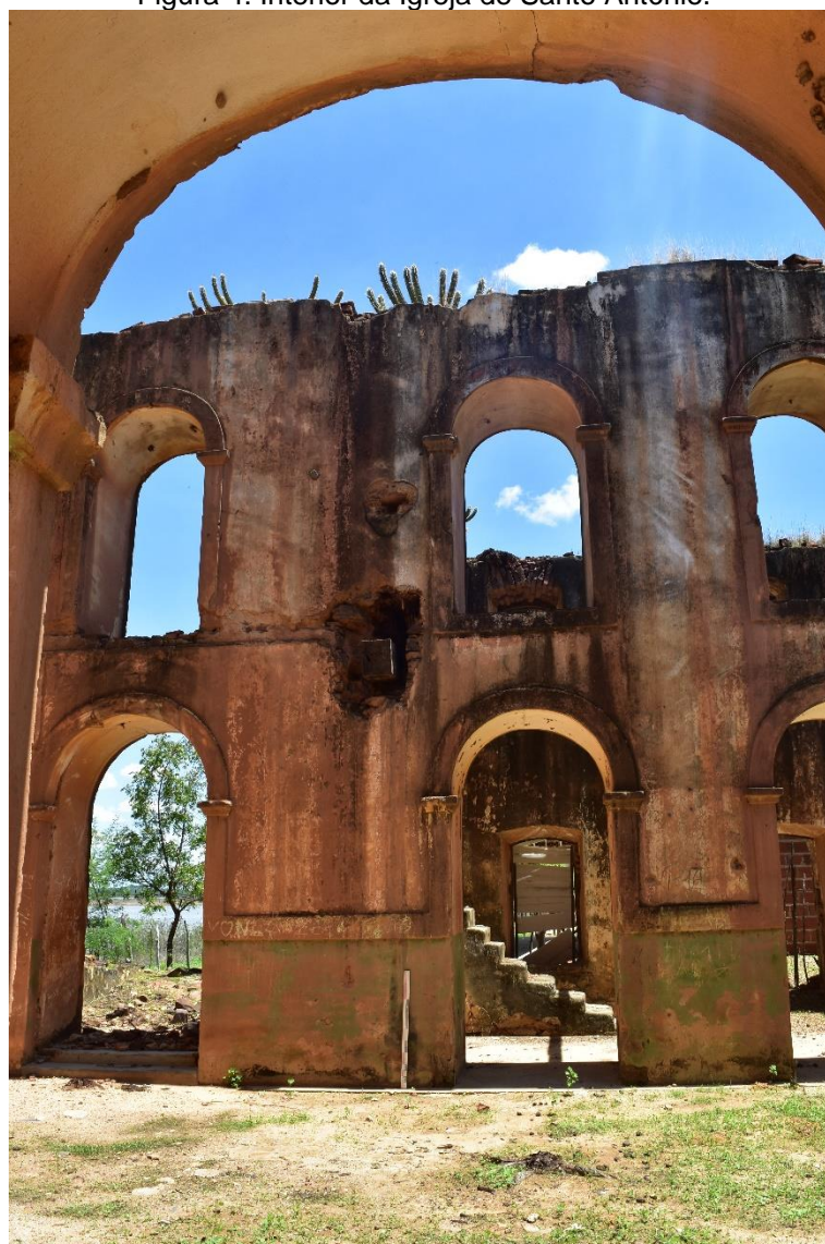
Figura 4: Interior da Igreja de Santo Antônio.
