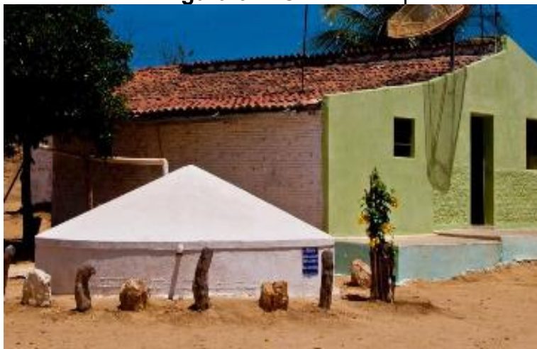
Figura 02 – Cisterna de placas
