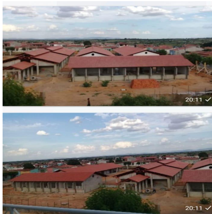
Figura 36 – Construção do Colégio Municipal
