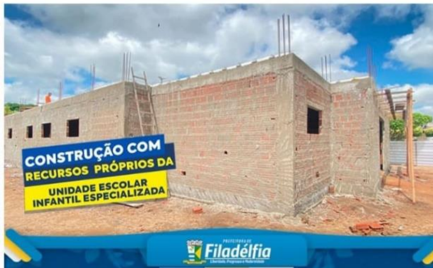
Figura 33 - Construção da CLIPEM
