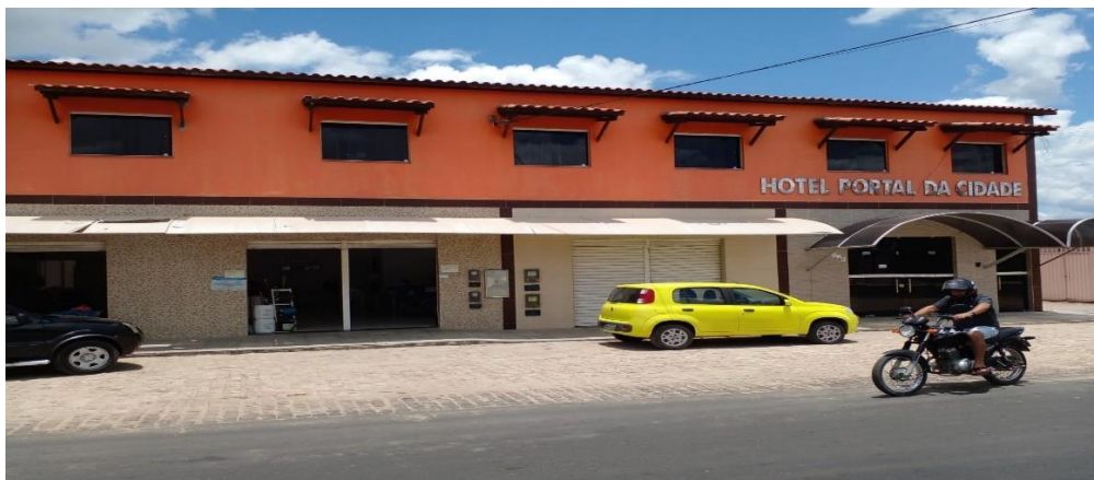
Figura 54 – Hotel Portal da Cidade, Avenida Eudaldo Mota
