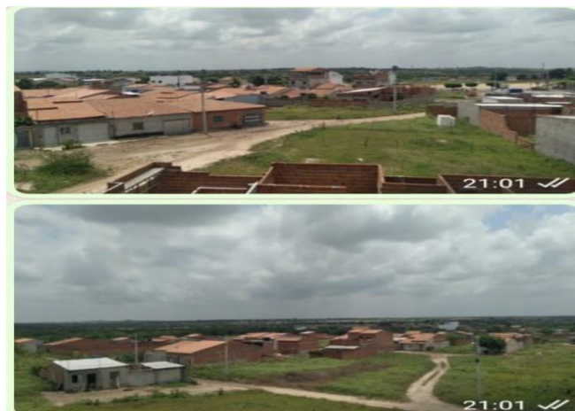
Figuras 56 – Edificações do Loteamento Recanto das Gaivotas
