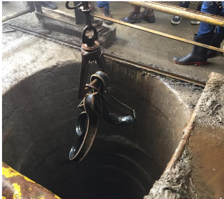
Foto 10 – Estrutura de perfuração no solo para a descida dos garimpeiros
