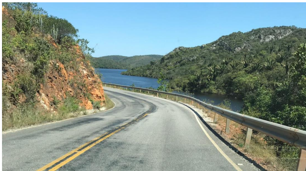
Foto 09 – Trecho da BA – 372 ao lado da Barragem de Pindobaçu
