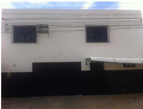
Figura 14: Área de carga/descarga. Fonte: Acervo pessoal (2015).
