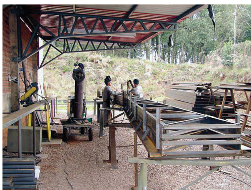
Figura 5: Montagem da estrutura
